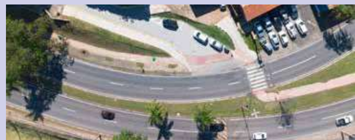
O novo acesso já está liberado para o trânsito
