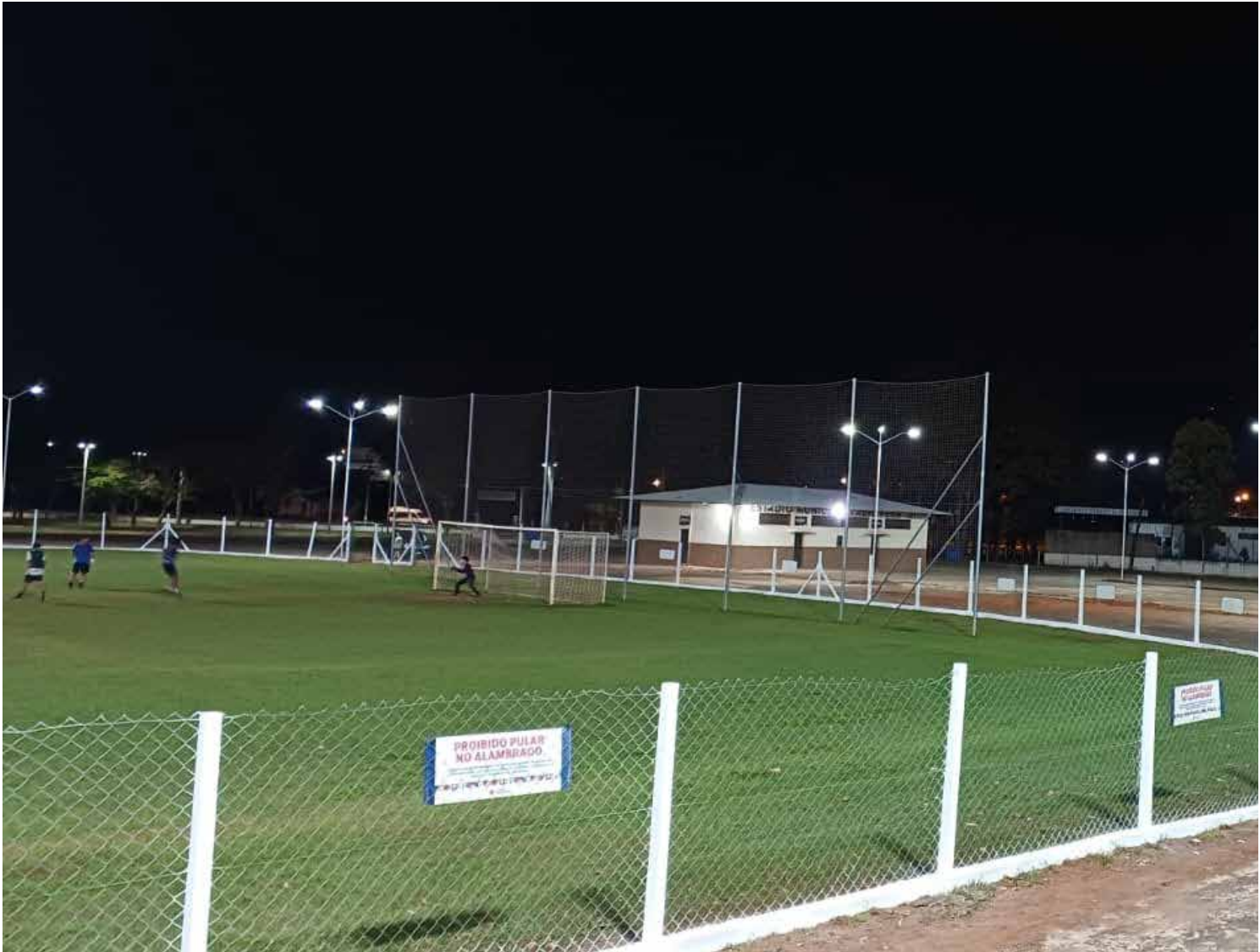
Outras melhorias ainda estão sendo executadas
