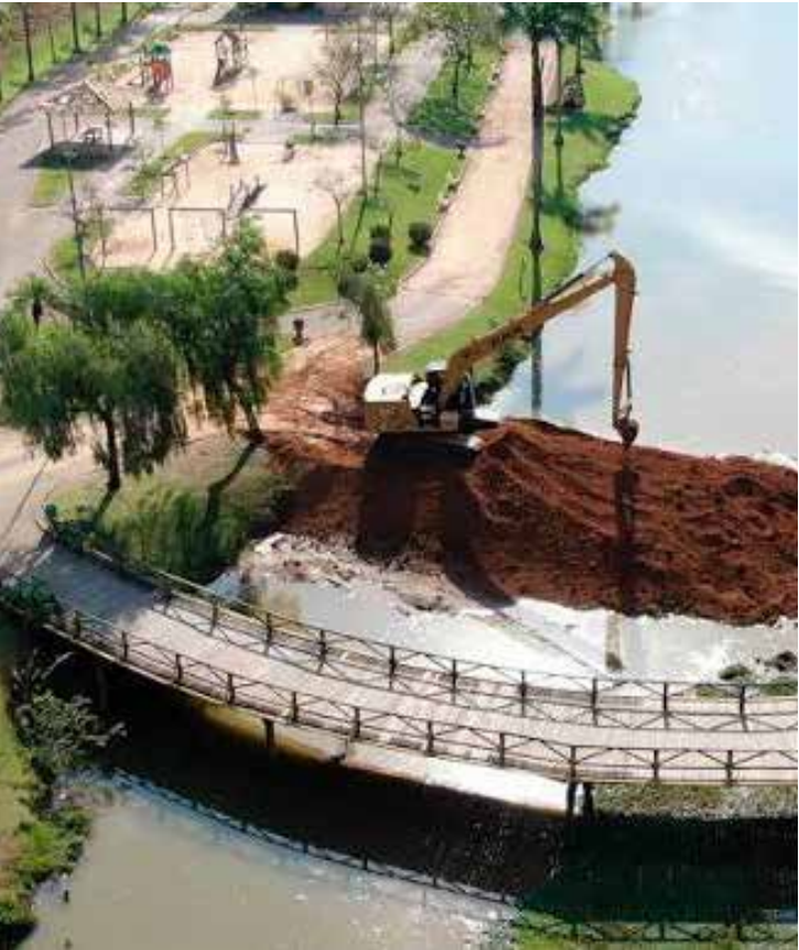
O desassoreamento prevê a retirada de aproximadamente 2.700 m³ de sedimentos
