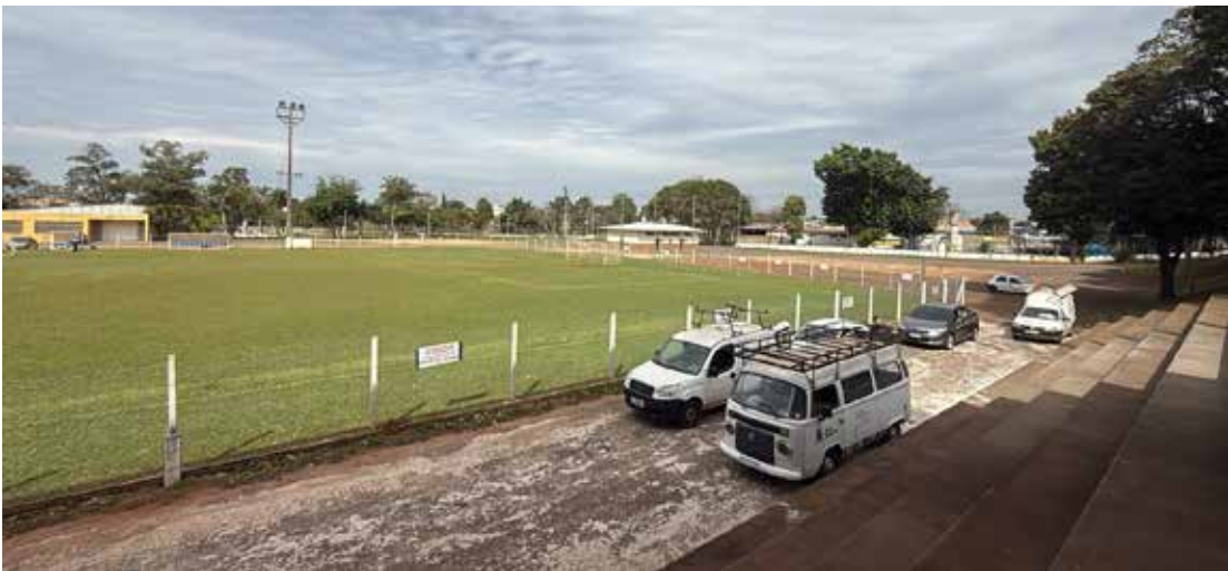
A primeira etapa da obra consiste na instalação de uma nova iluminação no local
