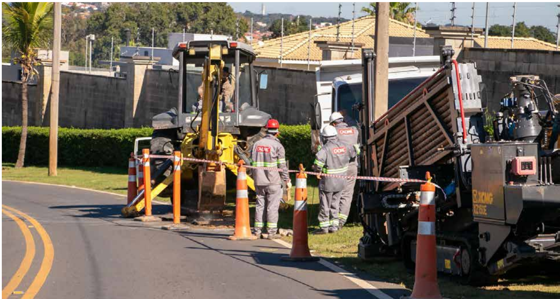
A nova adutora ampliará a capacidade de transporte de água tratada
