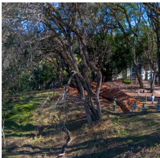
A obra coloca Jaguariúna muito próxima de atingir 100% de esgoto tratado
