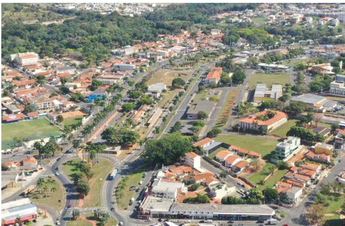
O prazo estimado para conclusão dos trabalhos é de 12 meses
