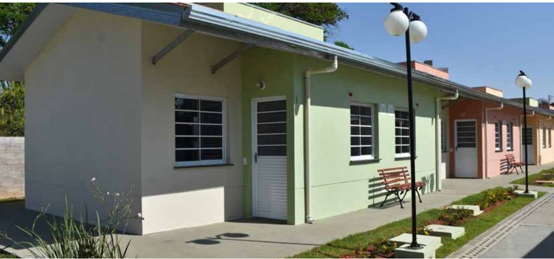
As casas serão construídas em um terreno doado pela Prefeitura
