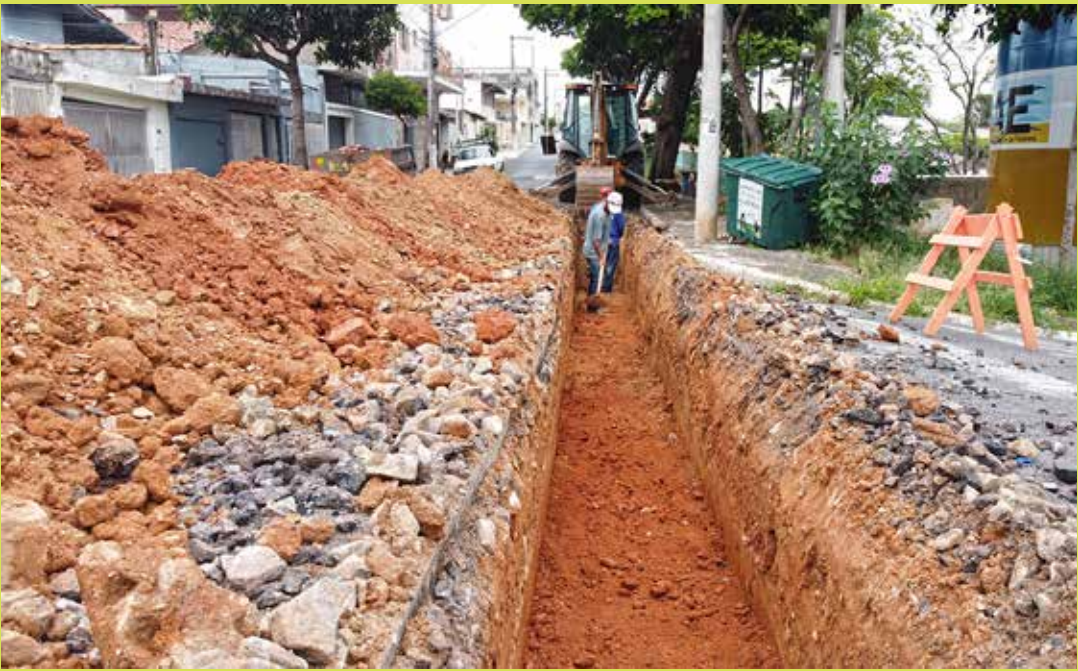
Estão sendo implantados 300 metros de rede de água com tubos de 6 polegadas, ligando a antiga caixa d'água da Xicara com o novo reservatório
