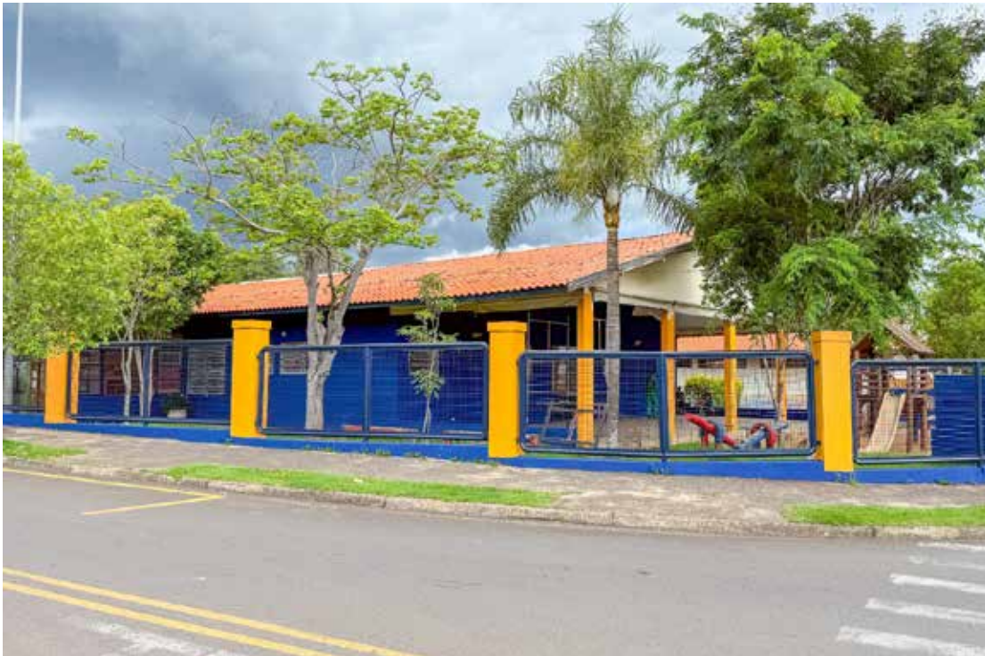
Os serviços estão sendo executados por equipes próprias da Secretaria de Obras
