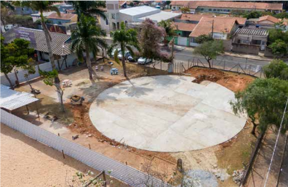
O novo reservatório terá capacidade para armazenar 1,2 milhão de litros de água
