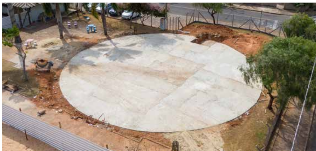
O novo reservatório terá capacidade para armazenar 1,2 milhão de litros de água
