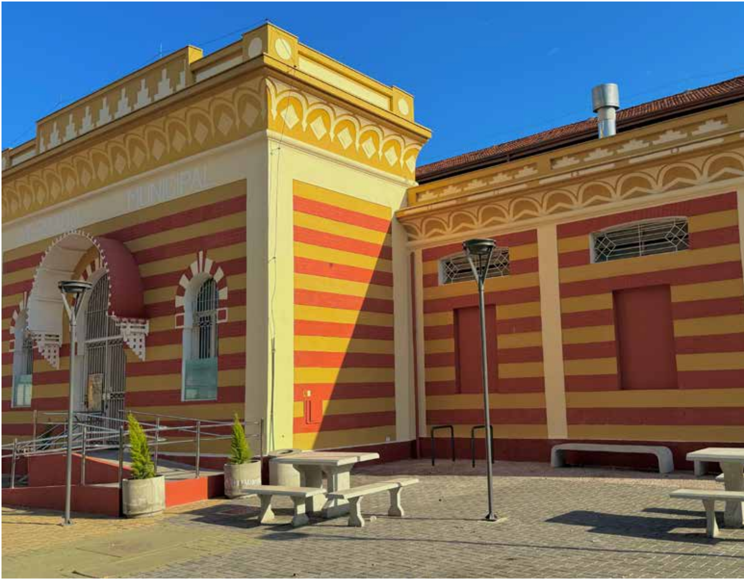
Foi investido cerca de R$1,6 milhão na restauração completa da estrutura do prédio e do entorno
