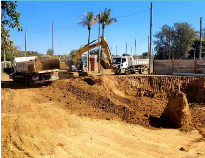
A obra tem conclusão prevista para o final de dezembro deste ano
