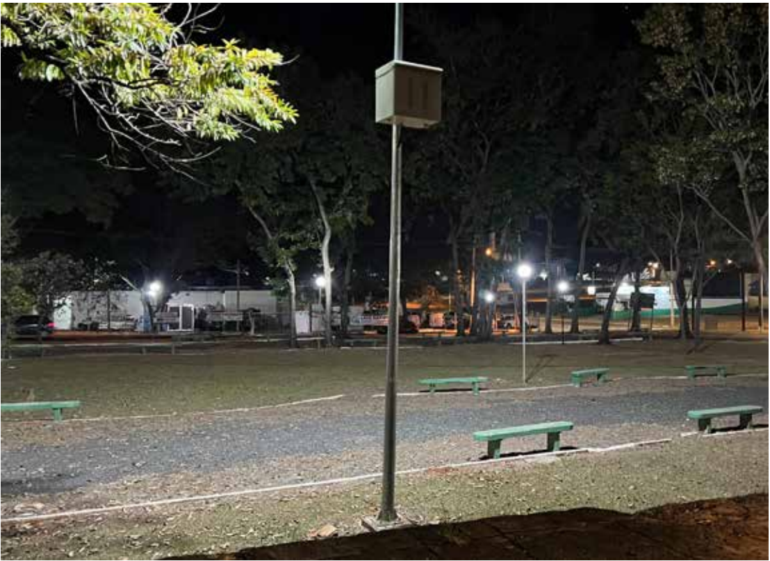
Prefeitura instalou nova iluminação na praça da entrada da cidade; rodoviária e calçadão da XV também já foram contemplados
