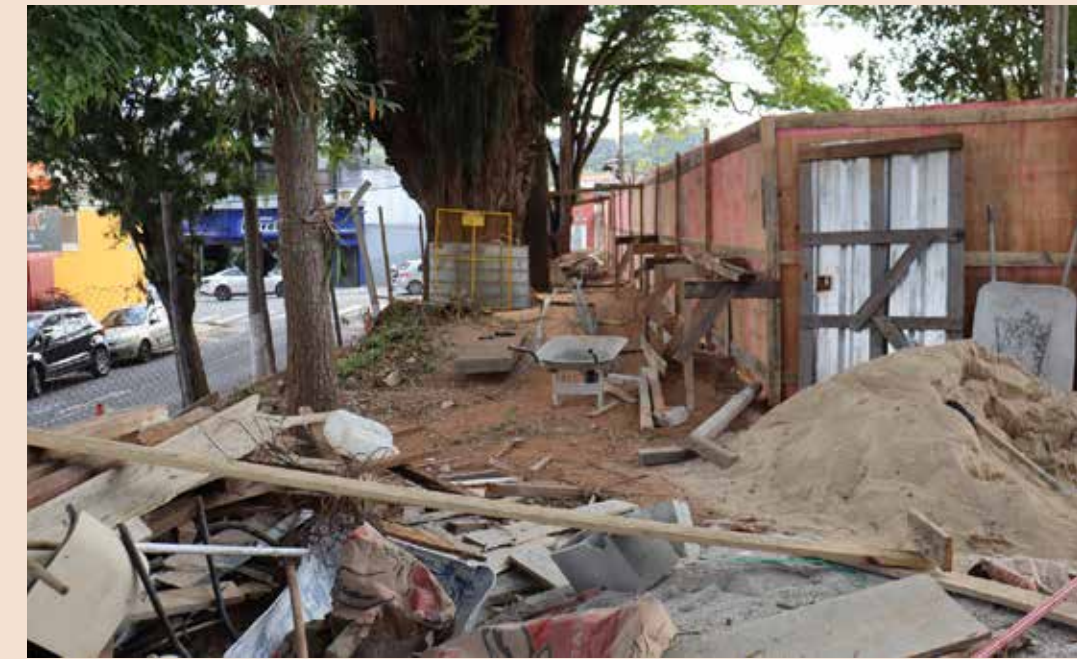
Obras de reforma em escola de Pedreira
