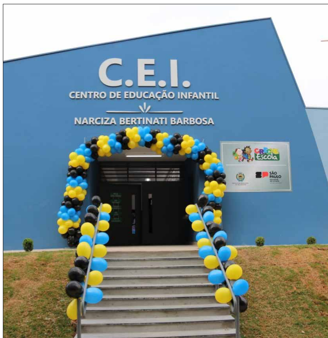
A construção da creche aqui foi retomada há cerca de três meses
