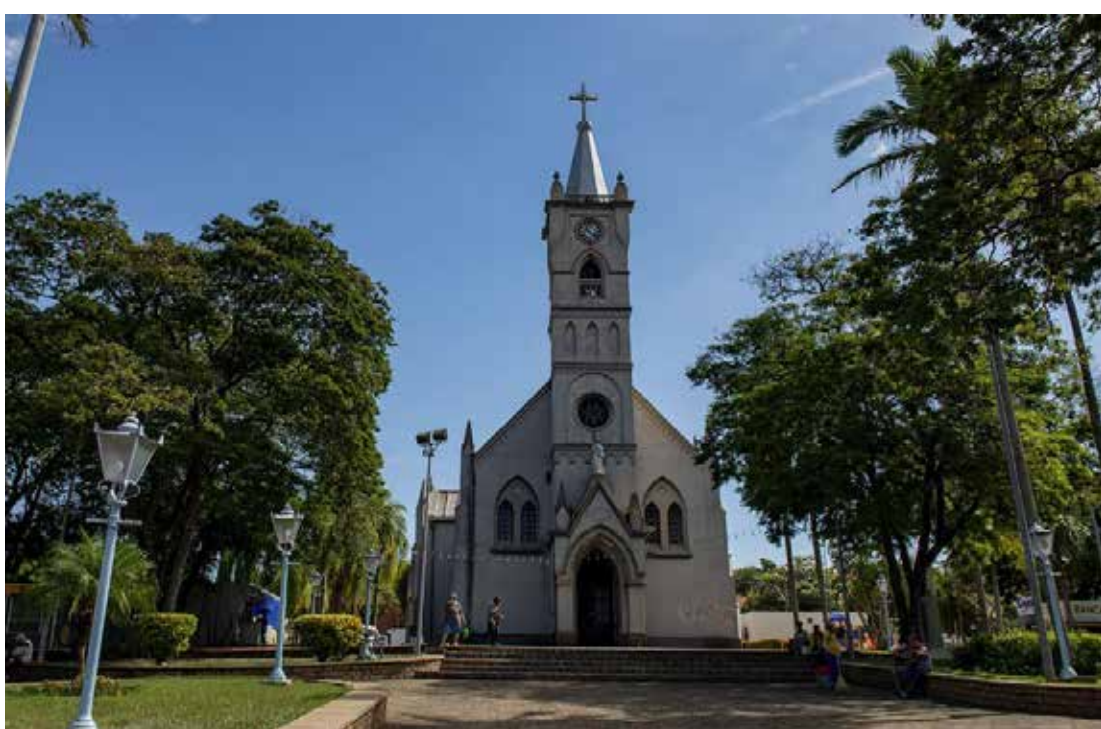
Igreja Matriz Centenária - em processo de restauro
