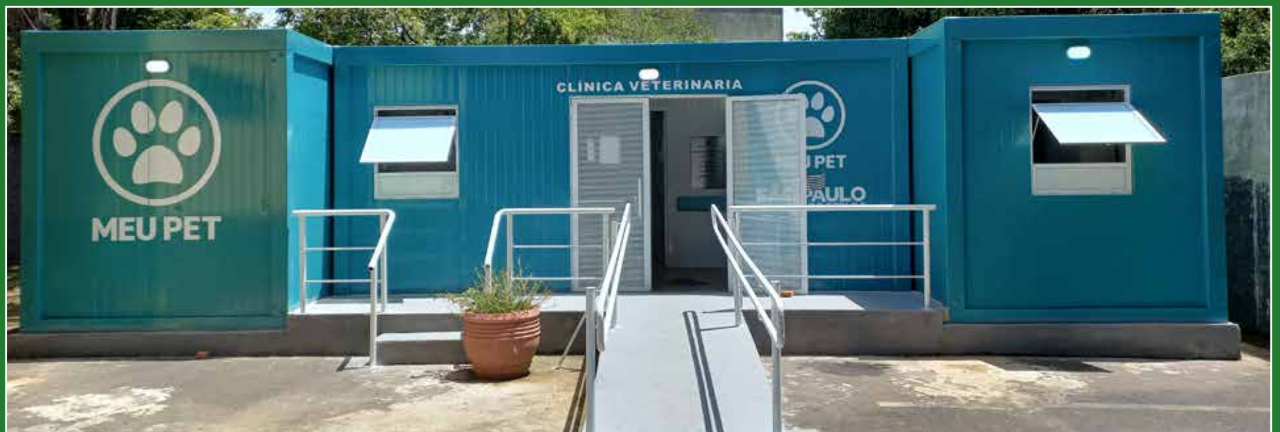
O Consultório Veterinário “Meu Pet Container - Sylvio Lazarini” está situado na Rua Miguel Sarkis, nº 61, Parque Industrial
