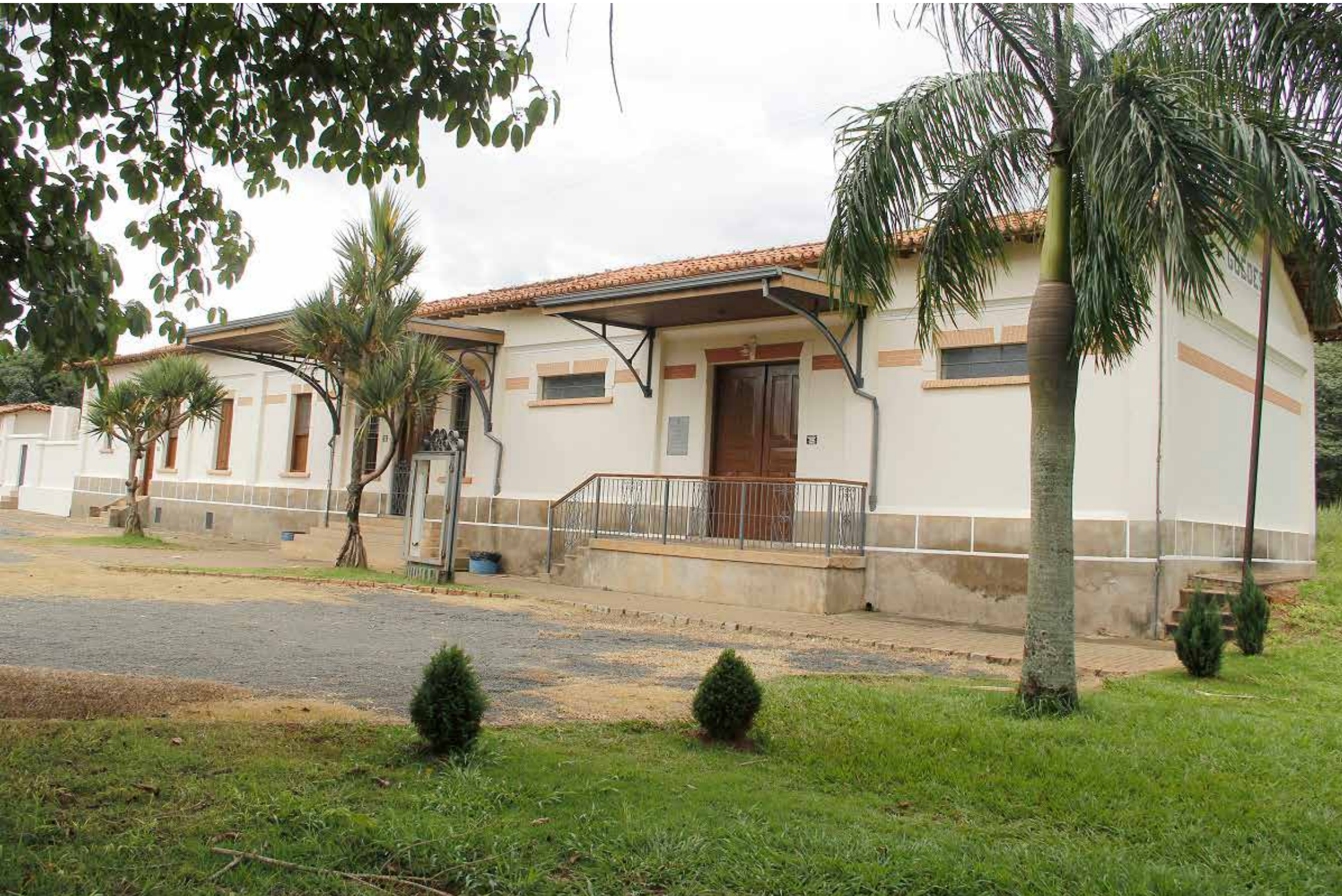
A Estação de Guedes foi inaugurada em 1945 e passou por processo de restauração em 2012
