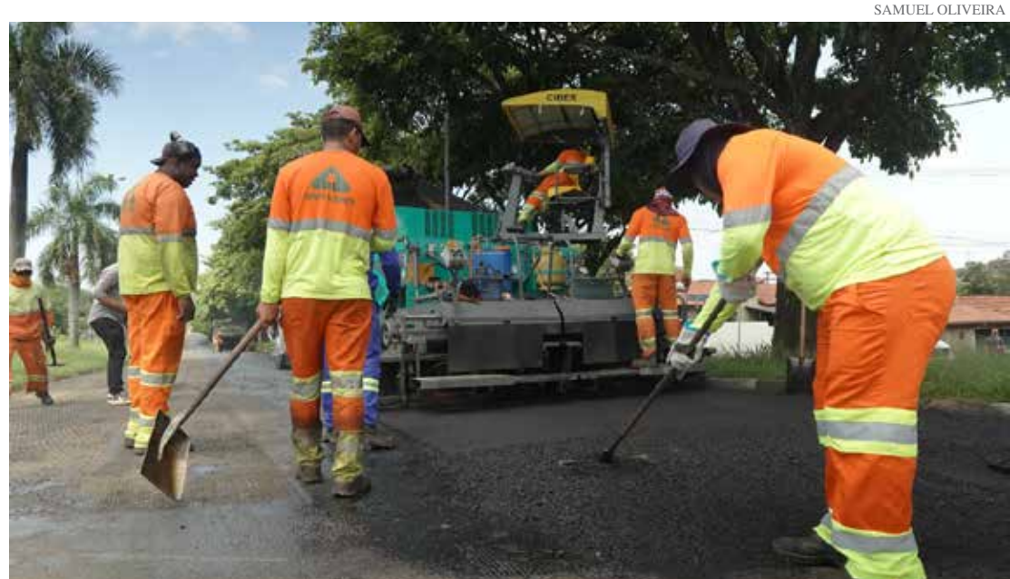
Massa asfáltica sendo aplicada na Avenida Luciano Poltronieri
