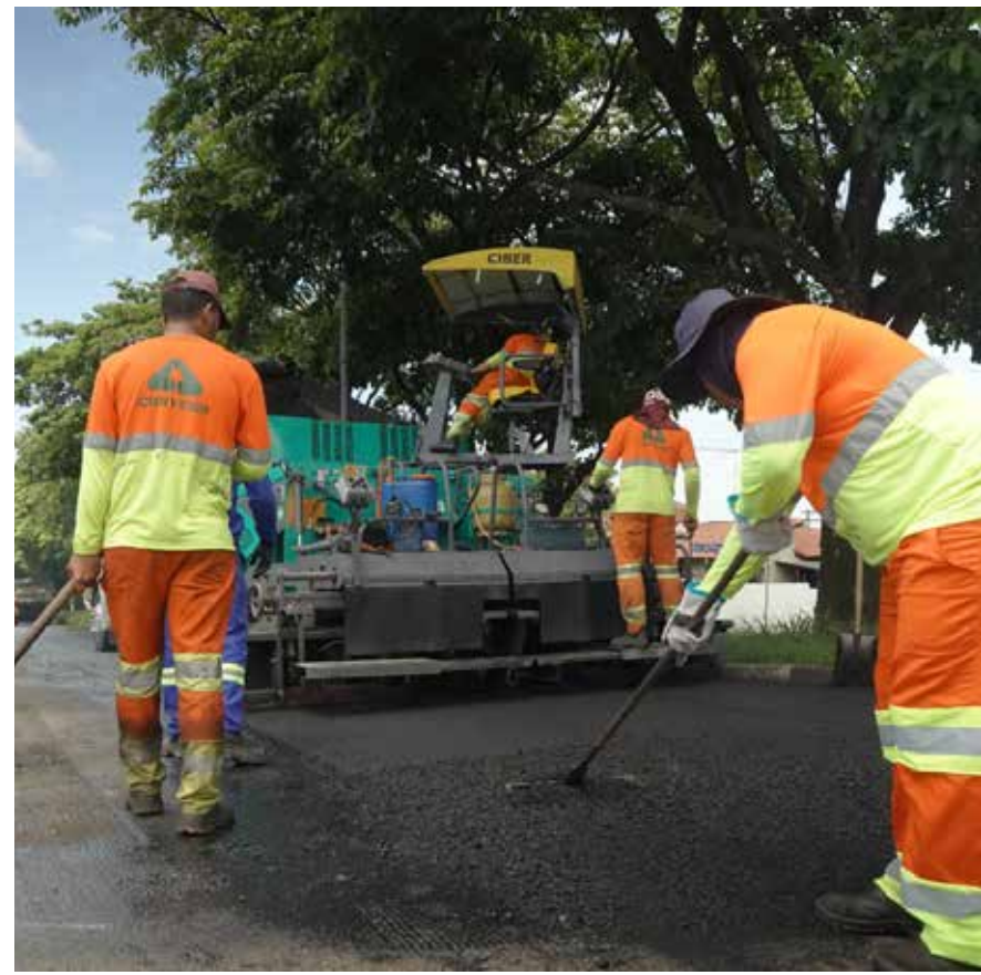
Massa asfáltica sendo aplicada na Avenida Luciano Poltronieri
