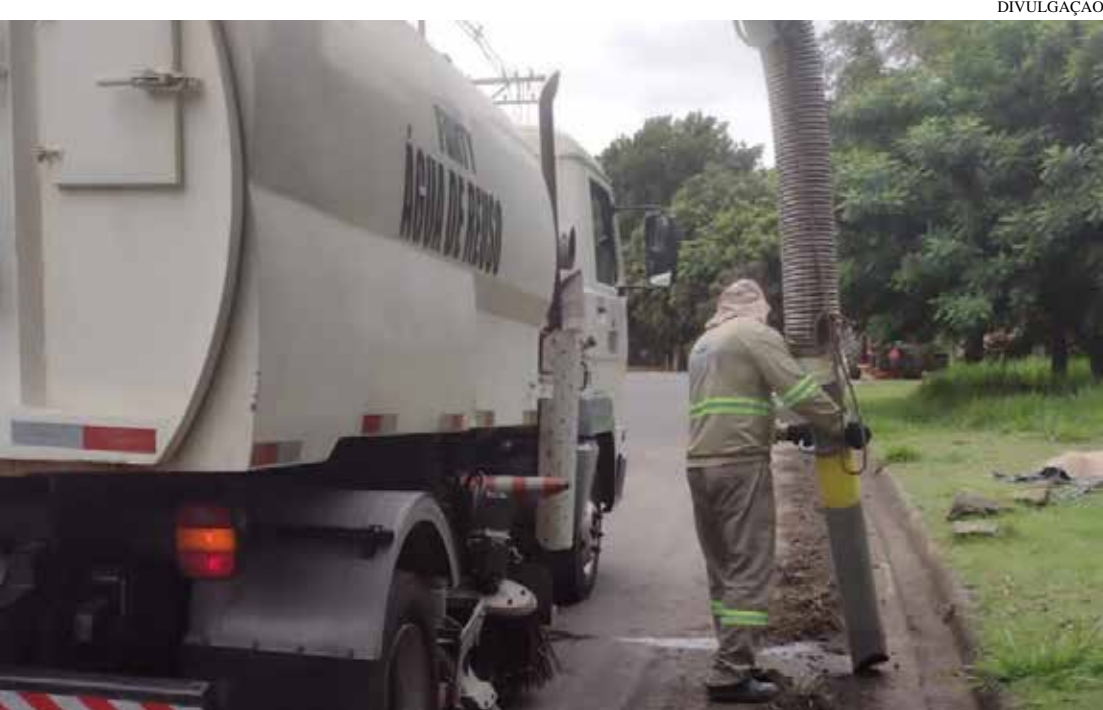
Hidrojato é utilizado nas bocas de lobo
