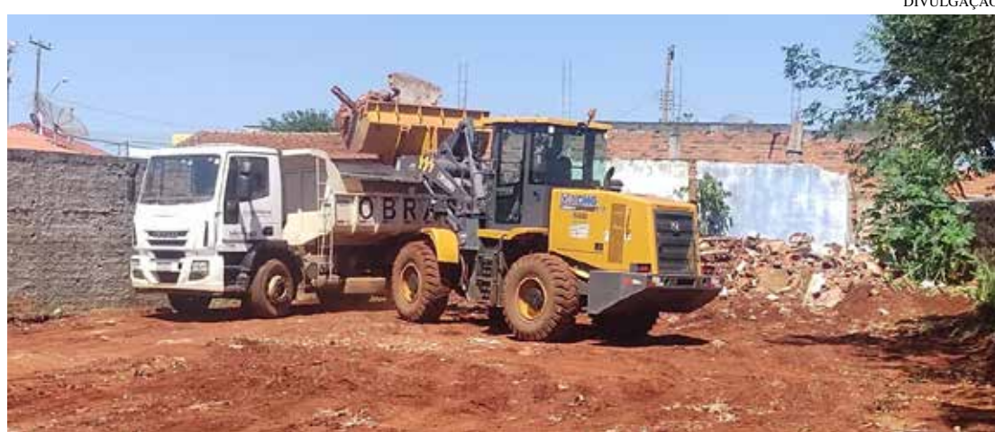
Desde o último fim de semana, o terreno, que fica na rua Pastor Octávio School, no centro, vem sendo limpo para receber o canteiro de obras para a construção do novo prédio
