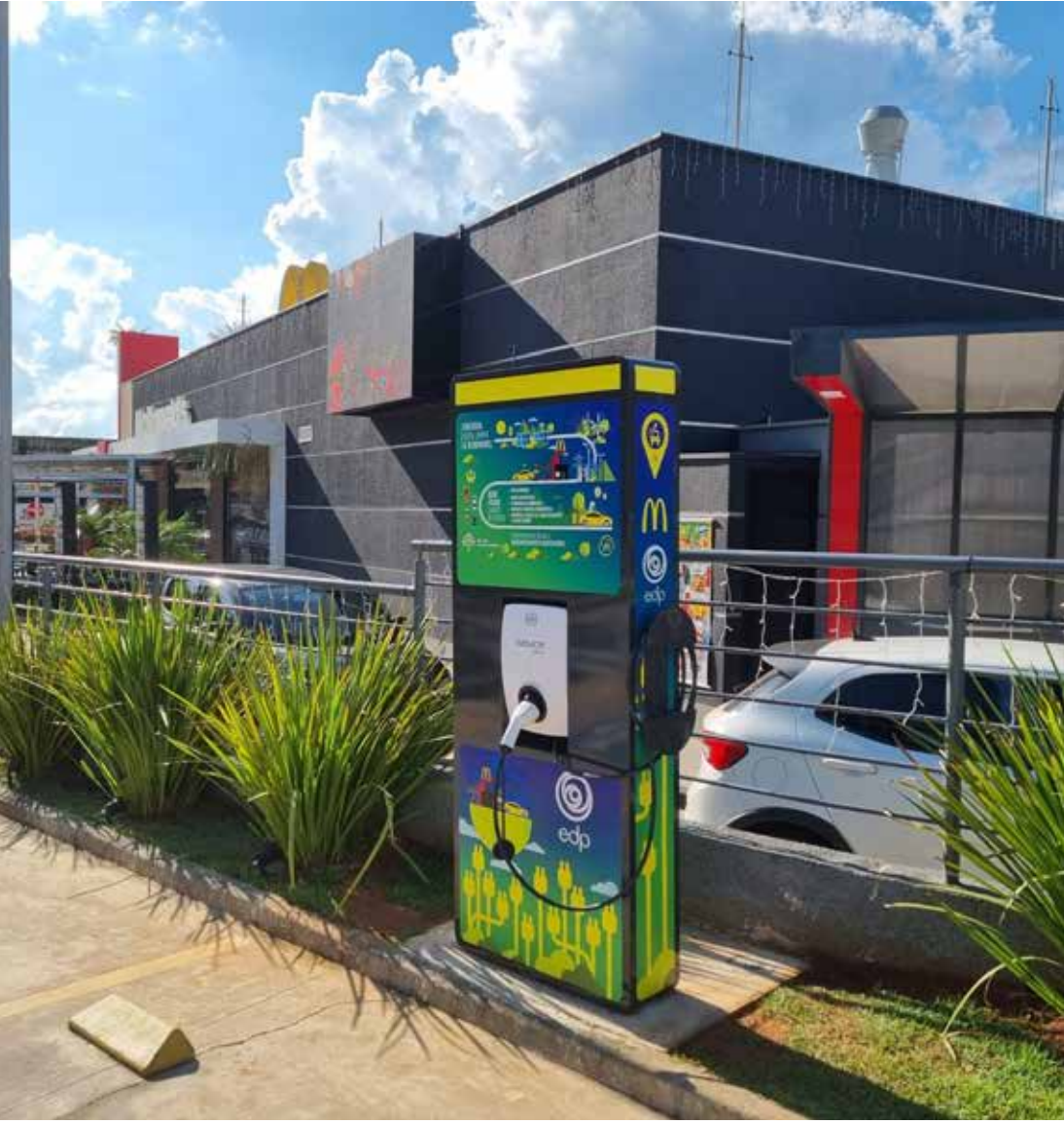
Abastecido com energia renovável, o eletroposto está instalado no estacionamento do restaurante
