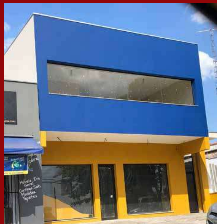
A construtora PHE iniciou os trabalhos no dia 1º de fevereiro
