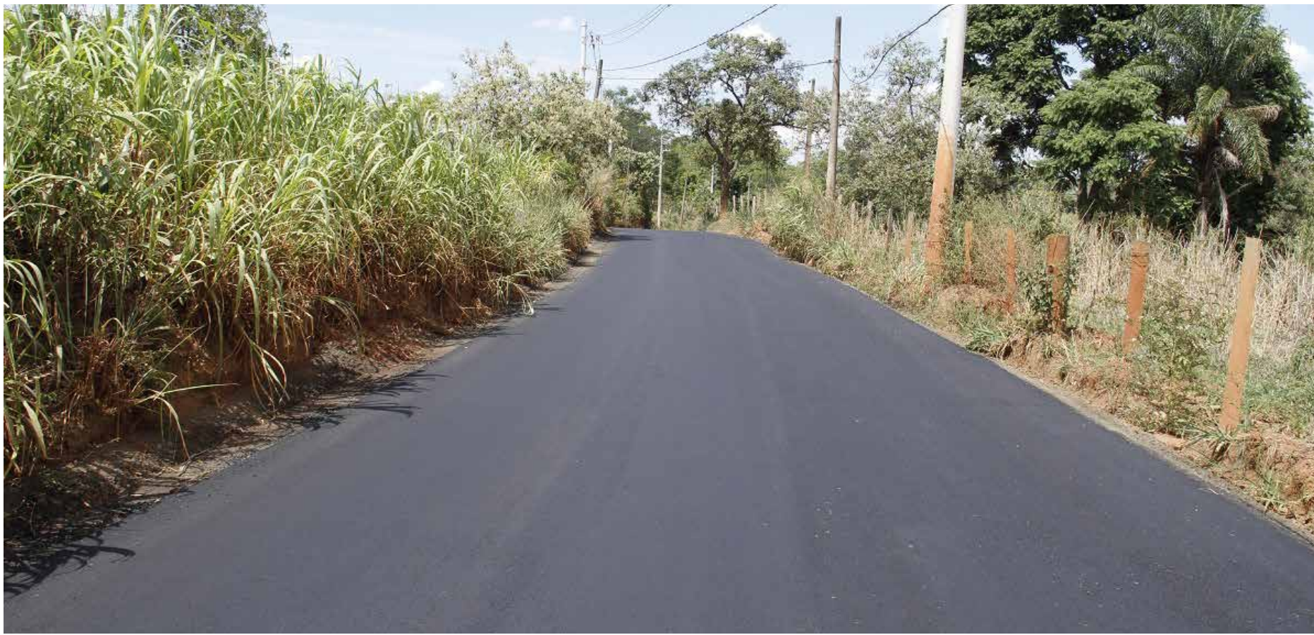
Na sequência será feito o trabalho de sinalização horizontal e vertical da estrada
