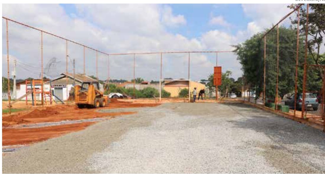
A obra está orçada em cerca de R$60 mil
