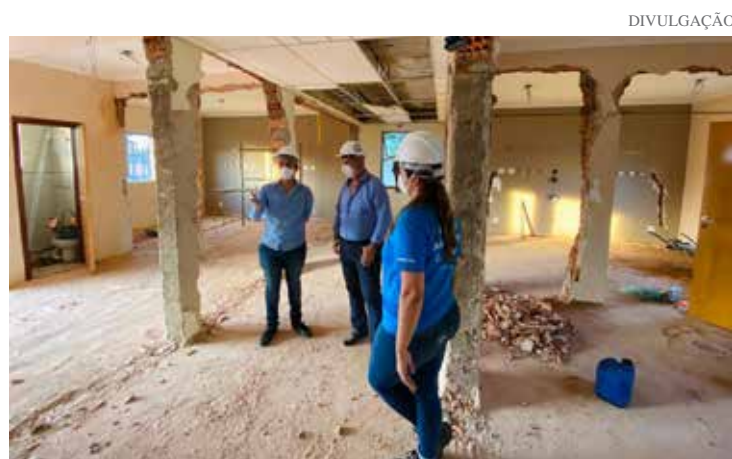
Autoridades visitam obra de reforma
