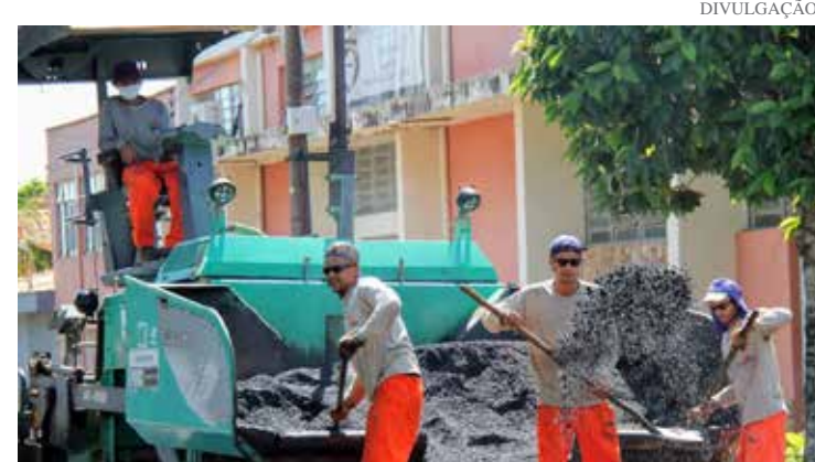
Trabalho de recapeamento
