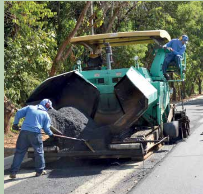
No município, outras oito ruas devem ser asfaltadas ainda neste ano
