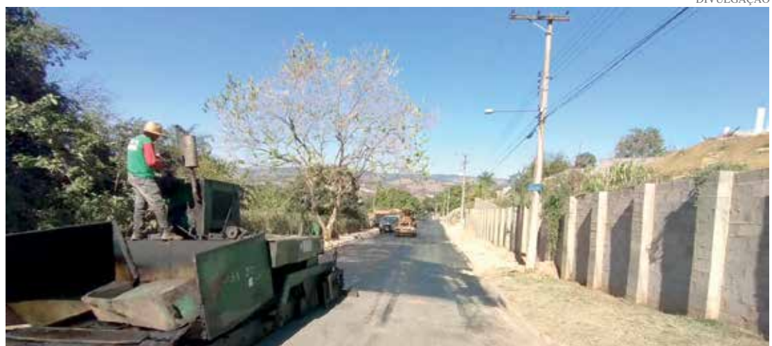
Diversas ruas da cidade devem ser asfaltadas ainda neste ano
