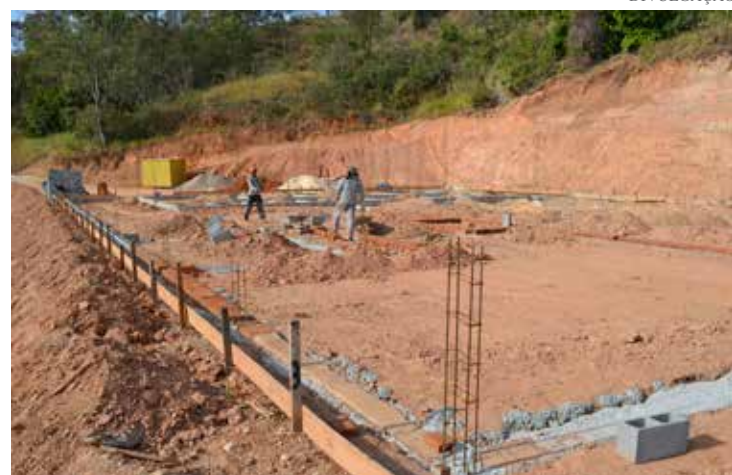
A construção fica ao lado da Praça de Esportes “Alcides Gritti”
