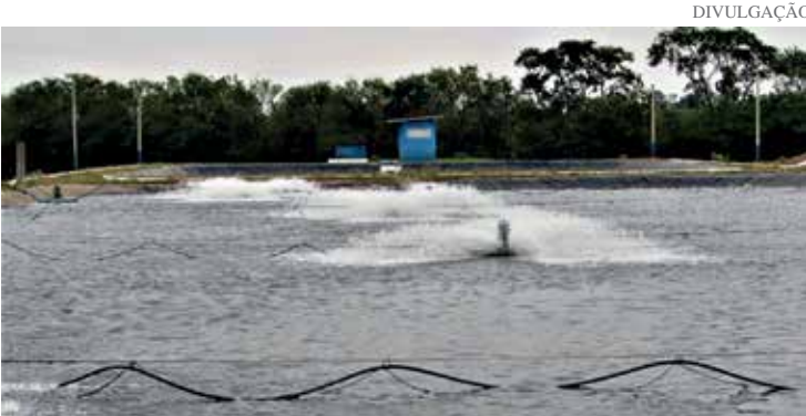
Instalação dos equipamentos garante maior eficiência no tratamento dos efluentes
