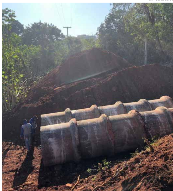
As obras já foram iniciadas
